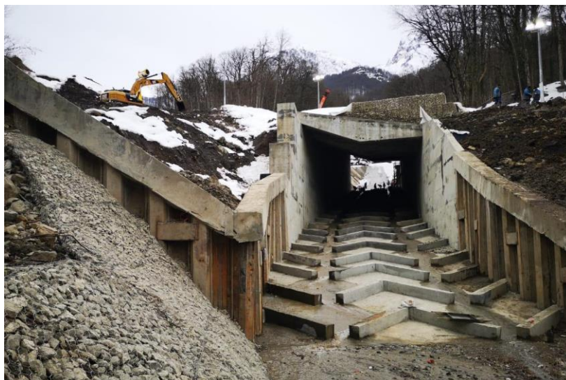
Рис. 4. Селепропускное сооружение закрытого типа, выполненное в горном кластере Сочи
