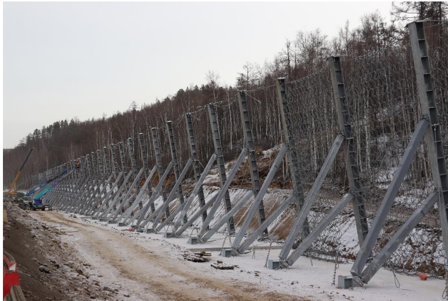
Рис. 9. Строительство селеудерживающего барьера на автодороге «Амур»
