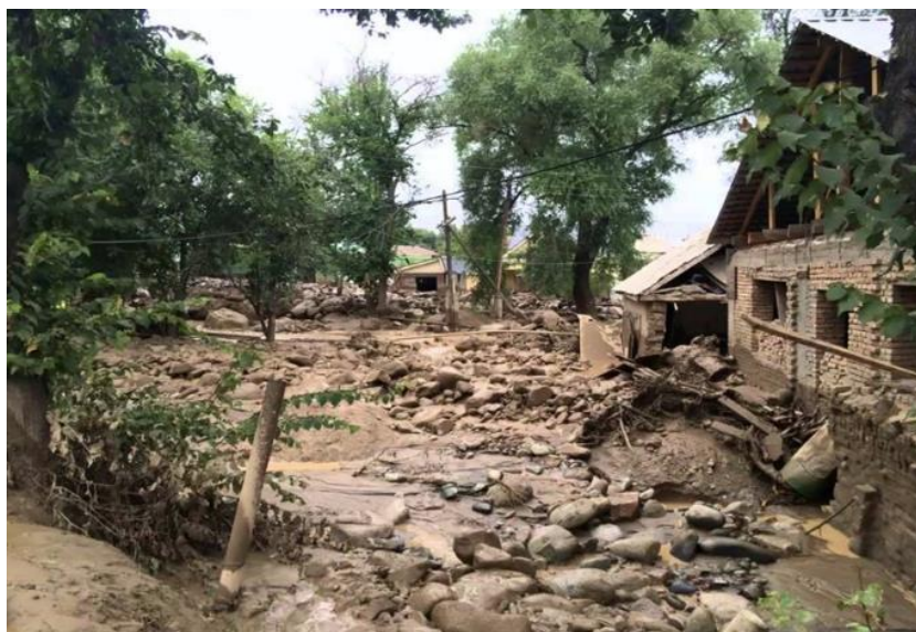
Рис. 1. Разрушения после селе в пос. Чадак Папского района Наманганской области Узбекистана, май 2016 г.
