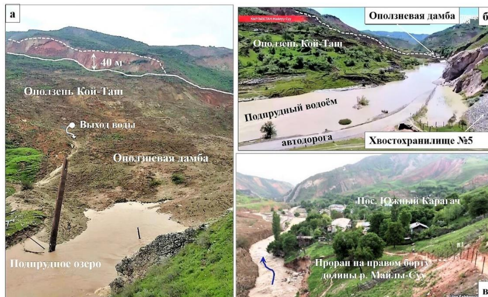
Рис. 3. Последствия оползневого блокирования р. Майлуу-Суу при обрушении оползня Кой-Таш 22 апреля 2017 г.: а – общий вид склона, оползневой дамбы и подпрудного озера; б – затопление основания удерживающей дамбы хвостохранилища № 5 и разрушенная новая автодорога; в – проран по правому борту долины р. Майлуу-Суу
