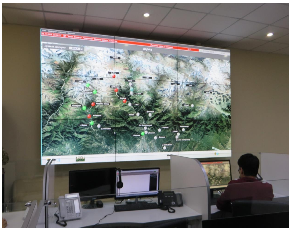
Рис. 3. Видеостена со станциями автоматизированного мониторинга селевой опасности в ситуационном зале Департамента по чрезвычайным ситуациям г. Алматы
